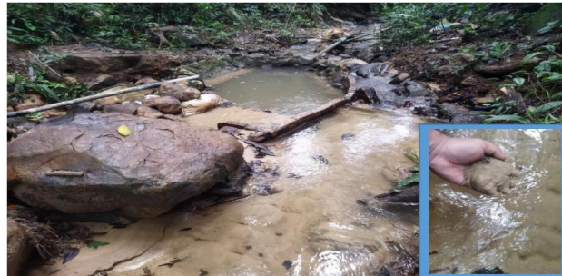
Rajah 5. Mendapan bendasing seperti lumpur dan pasir di empangan Paip Air Graviti Sumber: Kajian Lapangan 2021-2022.
