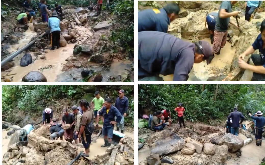
Rajah 6. Penduduk kampung bekerjasama membina/membaiki empangan paip graviti Sumber: Kajian Lapangan 2021-2022.
