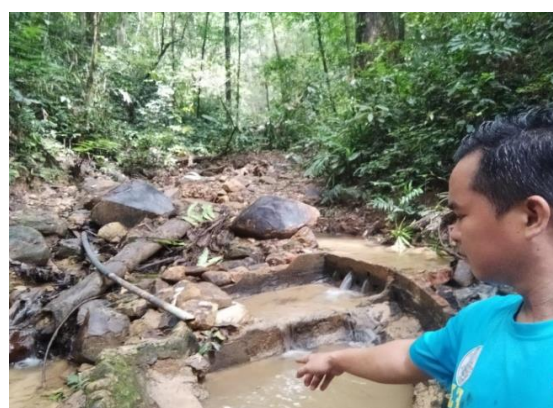
Rajah 3. Daun-daun dan ranting pokok yang menyekat aliran air memasuki saluran paip.
