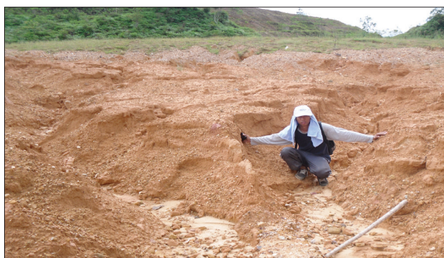
Rajah 5 Hakisan galur yang terbentuk akibat ketiadaan kawalan hakisan di permukaan Cerun K Sumber: Kerja Lapangan, 25 November 2011
