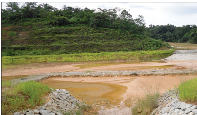
Rajah 3 Kolam takungan sedimen Sumber: Kerja Lapangan, 20 November 2011
