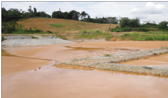
Rajah 8 Pemendakan sedimen di dalam Pond 4 serta pandangan hadapan Cerun K Sumber: Kerja Lapangan, 25 November 2011
